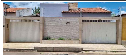
Representação Fachada Principal Descrição Data Foto 15/04/2024
