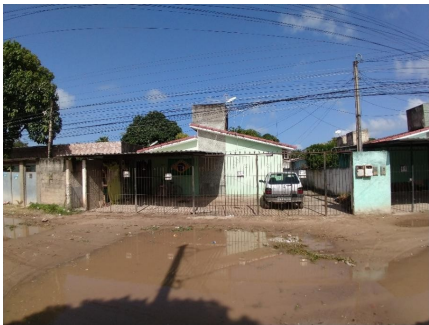
Representação Fachada Principal Descrição CONDOMÍNIO Data Foto 07/10/2022
