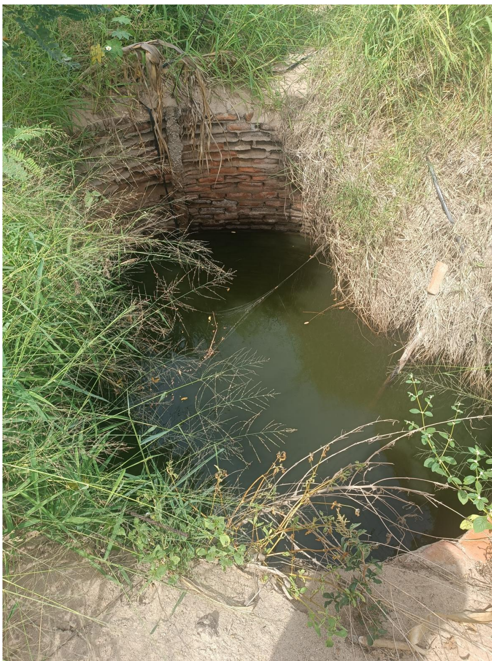
Poço cavado em leito de Rio
