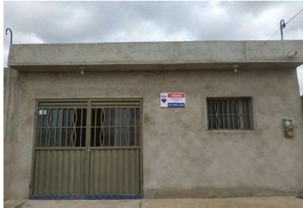
Representação Fachada Principal Descrição Data Foto 14/02/2024
