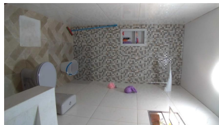
Representação Banheiro social Descrição Data Foto 09/09/2021
