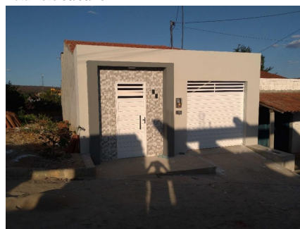
Representação Fachada Principal Descrição Data Foto 09/09/2021
