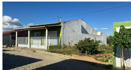
Representação Fachada Principal Descrição vizinho Data Foto 10/01/2024
