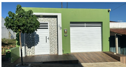
Representação Fachada Principal Descrição Data Foto 10/01/2024
