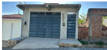
Representação Fachada Principal Descrição vizinho Data Foto 10/01/2024
