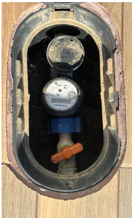
Representação Fachada Principal Descrição Medidor Data Foto 10/01/2024
