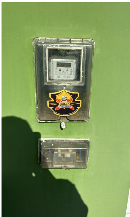
Representação Fachada Principal Descrição Medidor Data Foto 10/01/2024
