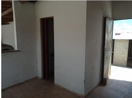
Representação Banheiro Descrição Banheiro externo Data Foto 13/04/2022
