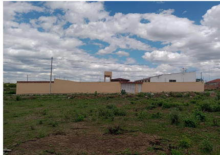
Representação Fachada Principal Descrição Data Foto 12/01/2024
