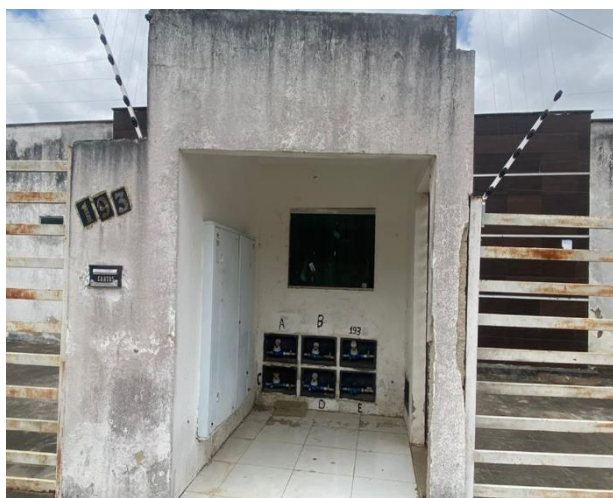
Vista parcial do condomínio
