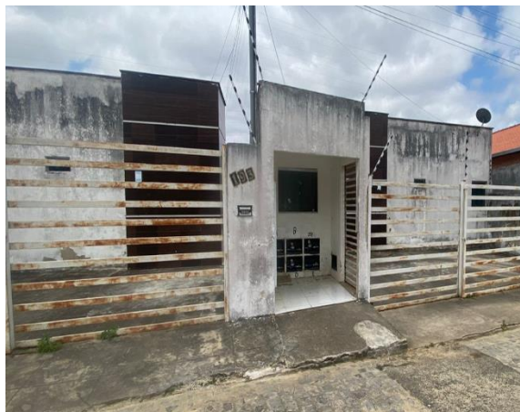
Vista parcial do condomínio
