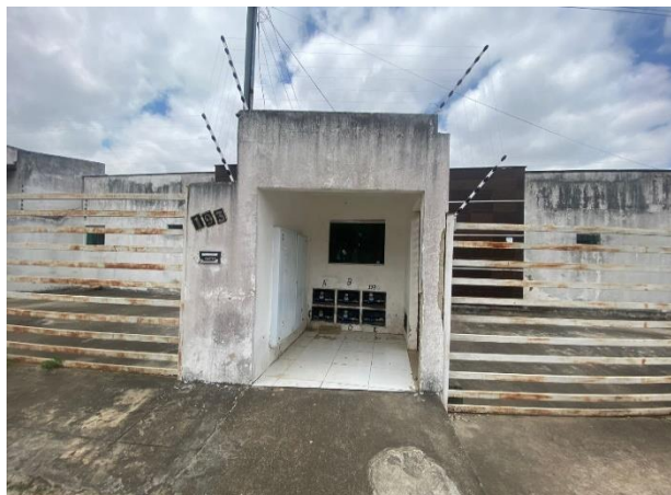
Vista parcial do condomínio
