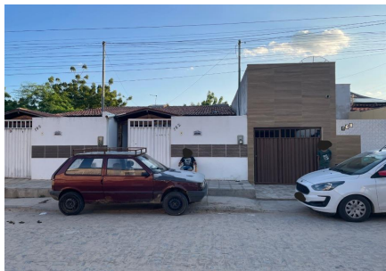
Representação Fachada Principal Descrição Data Foto 26/06/2024
