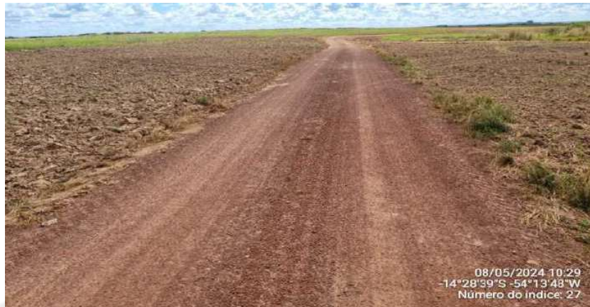
Estrada de servidão interna
