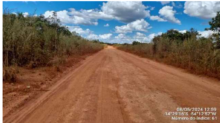
Rodovia MT - 020 – percurso de acesso de imóvel.
