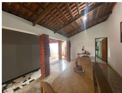
Representação Varanda / Sacada Descrição Data Foto 04/03/2022
