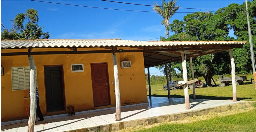
Sede com energia elétrica e varanda — vistoria mai/2024
