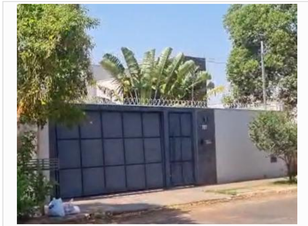
vista parcial da fachada
