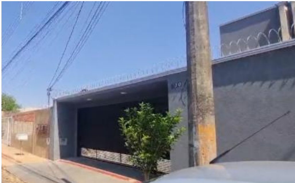
vista parcial da fachada
