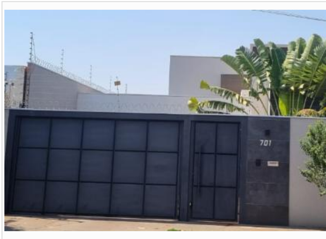
vista parcial da fachada
