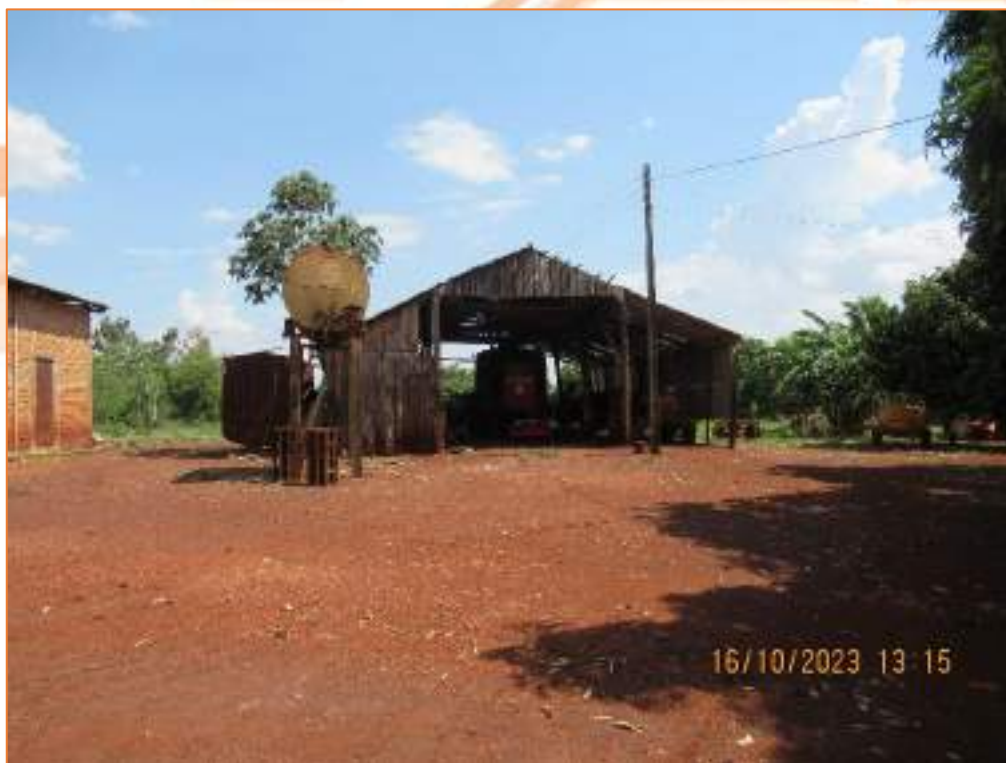
Figura 4 - Barracão de máquinas 2.
