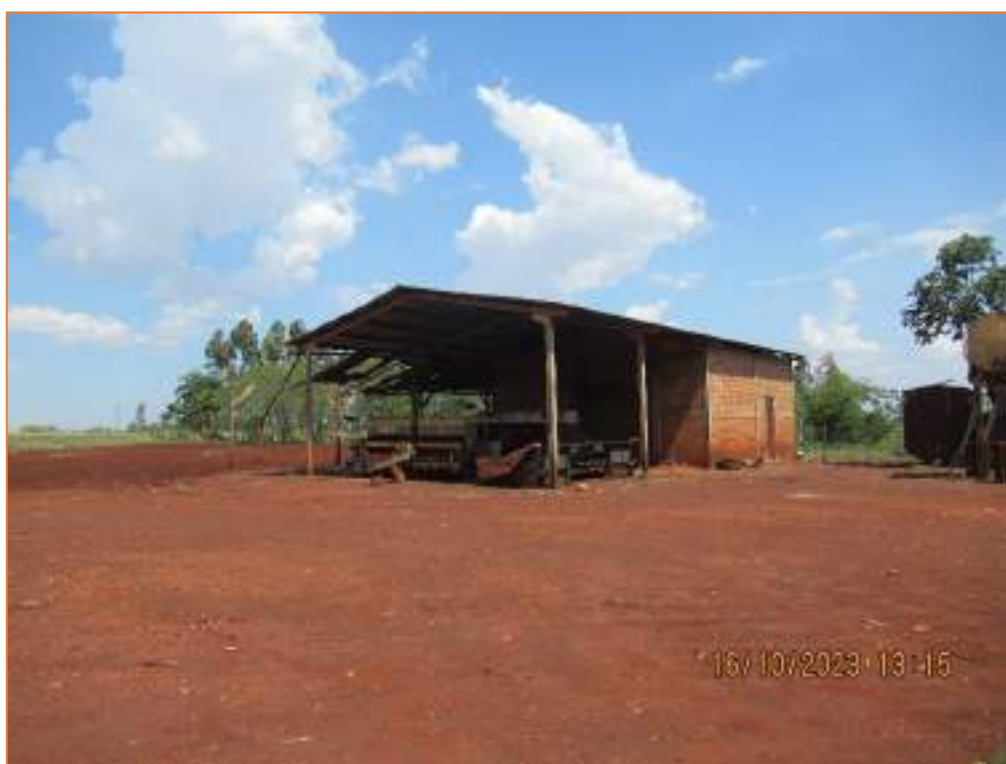
Figura 3 - Barracão de máquinas 1.
