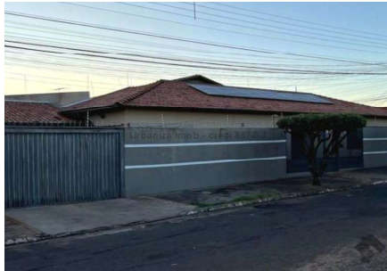
Representação Fachada Principal Descrição Data Foto 02/04/2024
