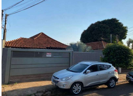
Representação Fachada Principal Descrição Data Foto 02/04/2024
