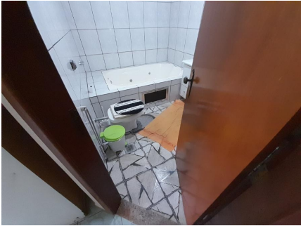
Representação Banheiro Suíte Descrição Data Foto 16/07/2022
