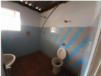
Representação Banheiro social Descrição Data Foto 16/07/2022
