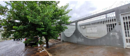
Representação Fachada Principal Descrição Data Foto 01/02/2024
