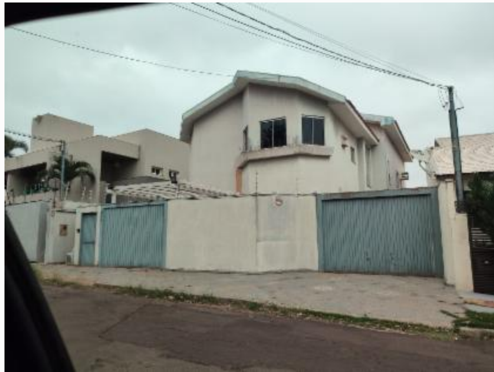
Fachada avaliando, vista 04
