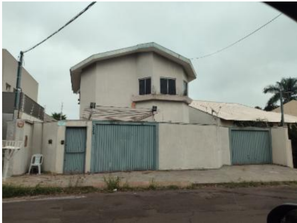
Fachada avaliando, vista 03
