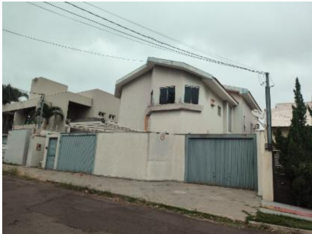
Fachada avaliando, vista 01
