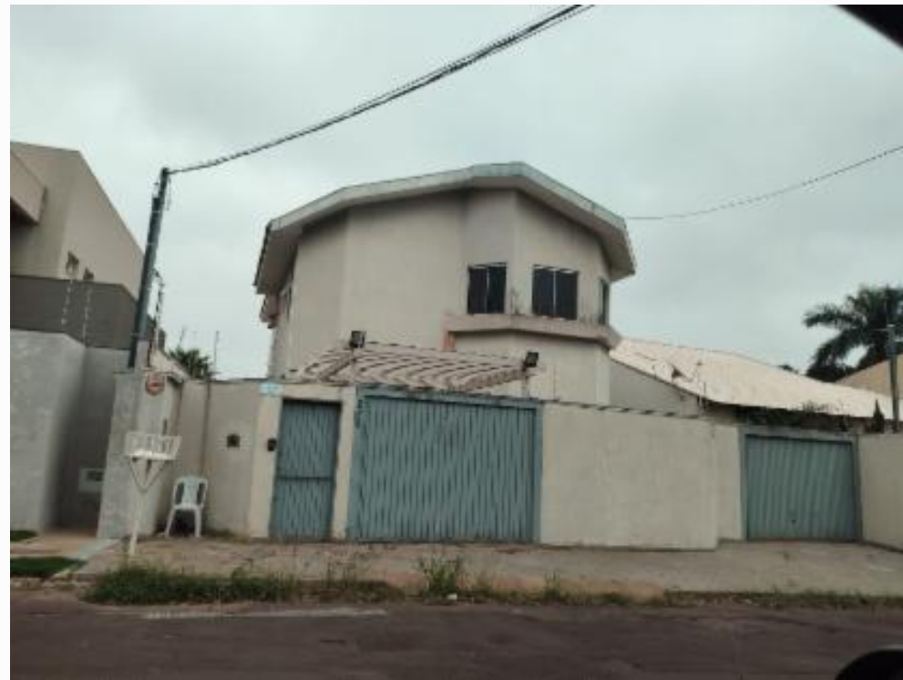
Fachada avaliando, vista 02
