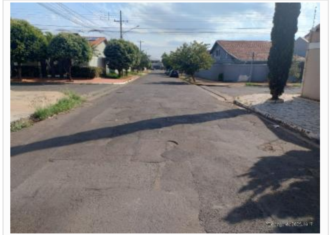
VISTA DA RUA
