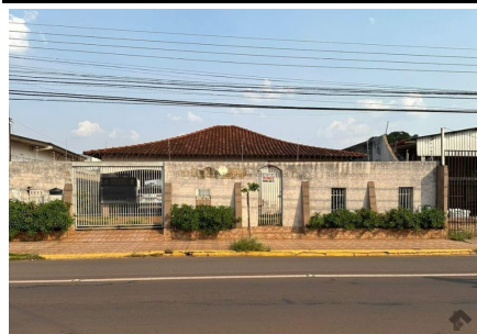
Representação Fachada Principal Descrição Data Foto
