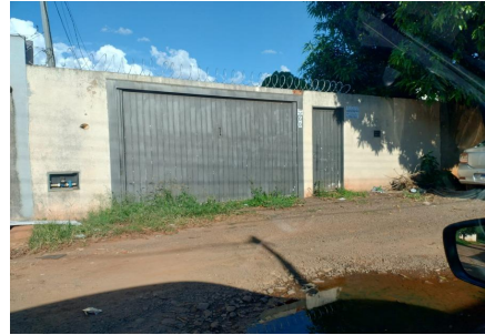
Representação Fachada Principal Descrição Data Foto 08/01/2024
