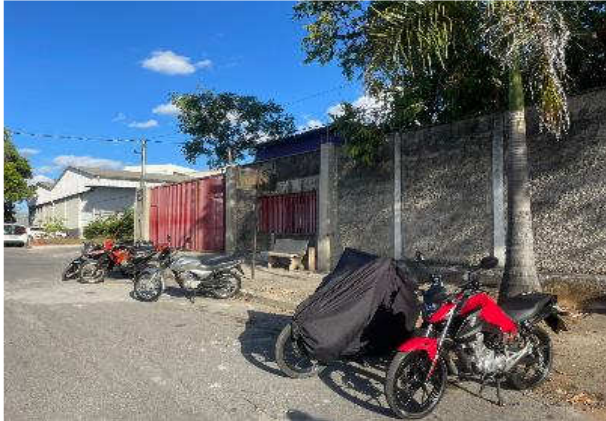
FACHADA/ACESSO PELA AV DOIS
