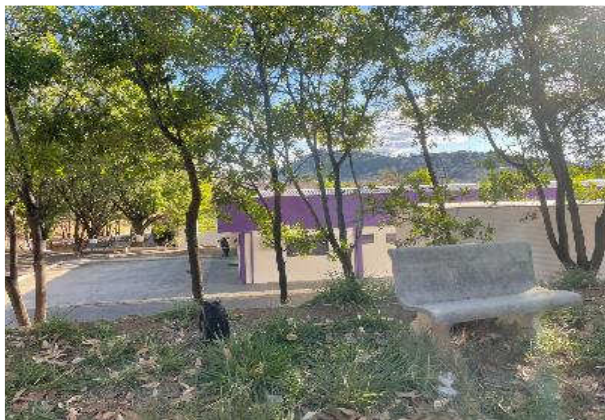
VISTA GERAL GALPÃO
