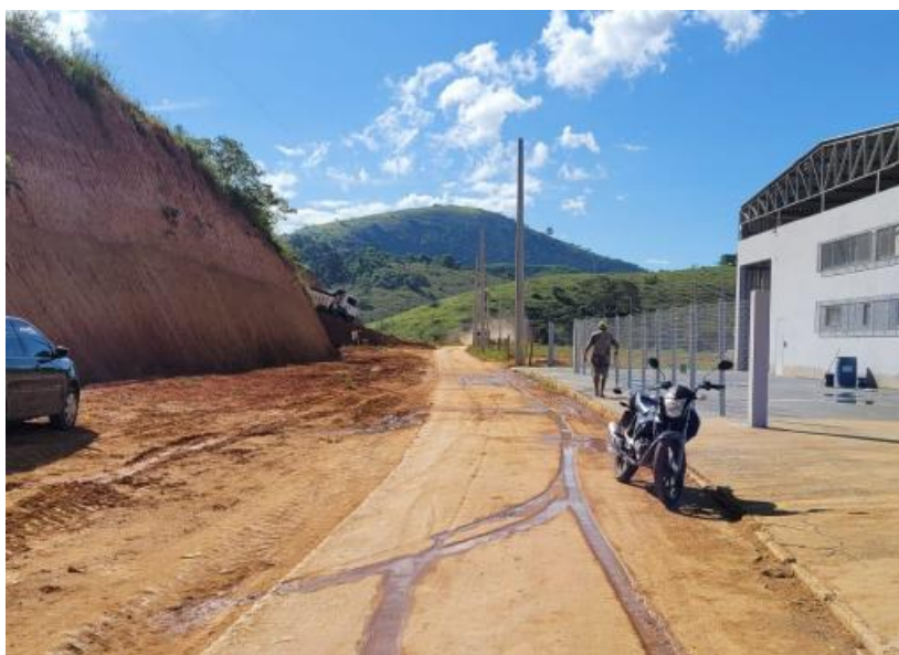
DETALHES DA VIA DE ACESSO AO IMÓVEL
