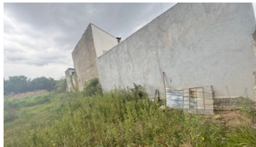
VISTA LATERAL ESQUERDA - LOTE
