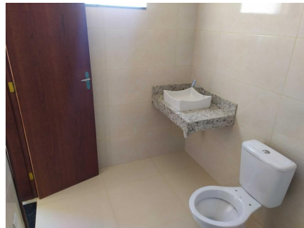
Representação Banheiro Suíte Descrição Data Foto 25/05/2021
