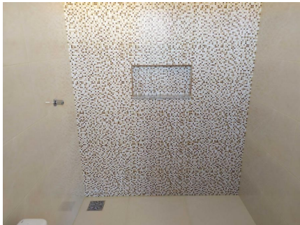
Representação Banheiro Suíte Descrição Data Foto 25/05/2021
