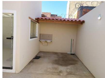
Representação Área de Serviço Coberta Descrição Data Foto 25/05/2021
