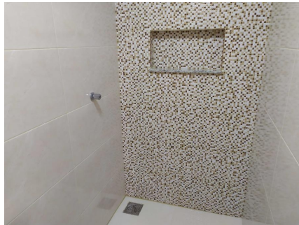
Representação Banheiro social Descrição Data Foto 25/05/2021
