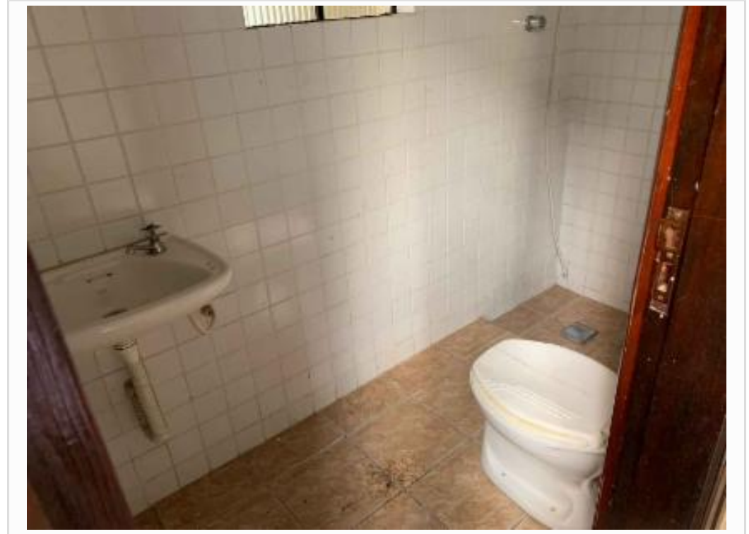
Edícula - Foto 3 - Banheiro
