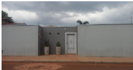
Representação Fachada Principal Descrição Data Foto 25/10/2023
