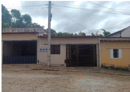
Representação Fachada Principal Descrição FACHADA IMÓVEL Data Foto 01/08/2024
