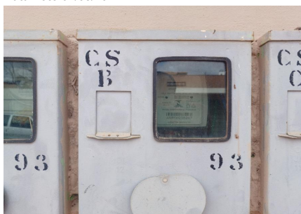
Representação Vista da Rua Descrição RELÓGIO Data Foto 01/08/2024
