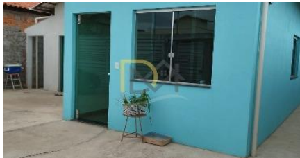
Representação Fachada Principal Descrição AMOSTRA 5 Data Foto 05/08/2024
