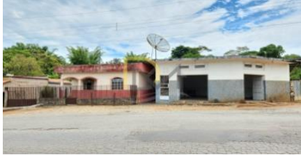
Representação Fachada Principal Descrição AMOSTRA 3 Data Foto 05/08/2024
