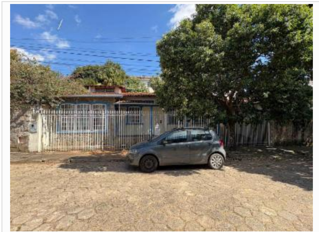
Fachada do avaliando
