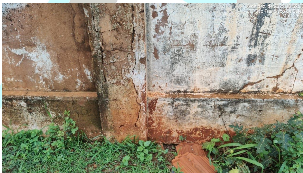
Figura 10 - Patologia por corrosão de armadura nos pilares na base da edificação
