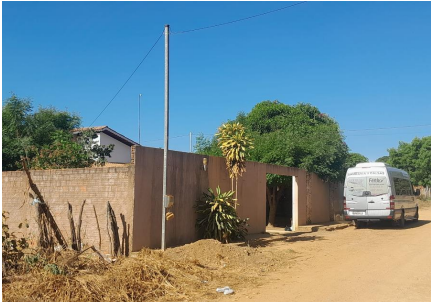
Representação Fachada Principal Descrição Data Foto 11/08/2023
