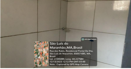
Representação Banheiro Suíte Descrição 1 Data Foto 13/12/2023
