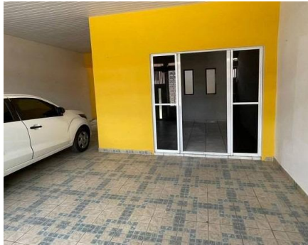
Representação Fachada Principal Descrição AMOSTRA 2 Data Foto 13/12/2023
