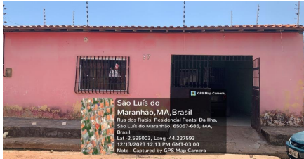
Representação Fachada Principal Descrição AVALIANDO Data Foto 13/12/2023
