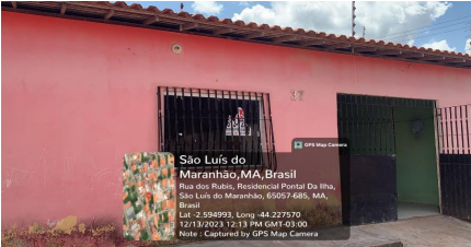
Representação Fachada Principal Descrição AVALIANDO Data Foto 13/12/2023
