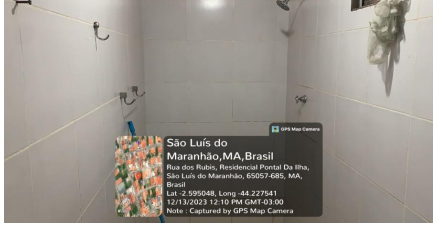
Representação Banheiro social Descrição Data Foto 13/12/2023
