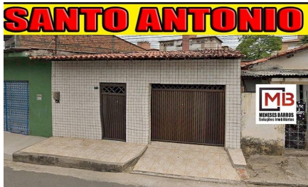
Representação Fachada Principal Descrição AMOSTRA 1 Data Foto 13/12/2023
