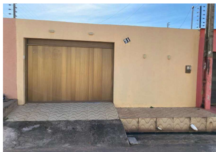
Representação Vista da Rua Descrição Vizinho à direita Data Foto 22/05/2024
