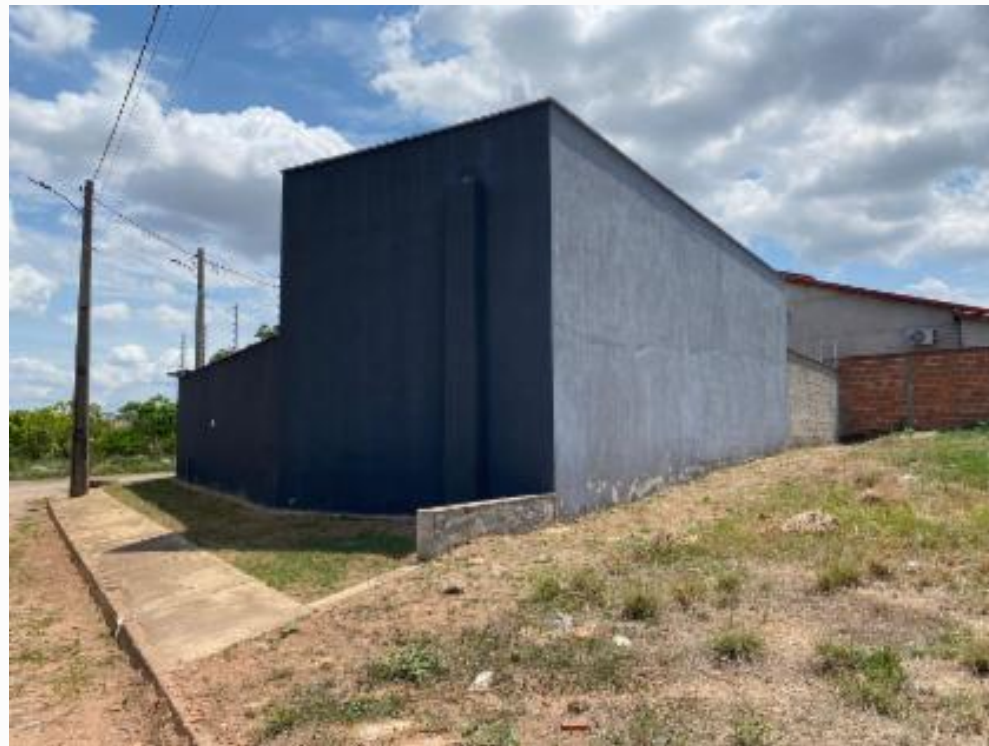
vista da fachada - lateral e fundos
