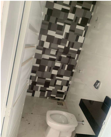
Representação Banheiro social Descrição Data Foto 05/12/2023
