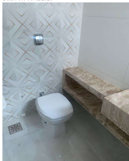
Representação Banheiro social Descrição Data Foto 05/12/2023
