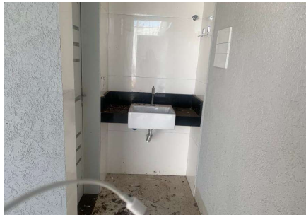
Representação Banheiro social Descrição Data Foto 05/12/2023
