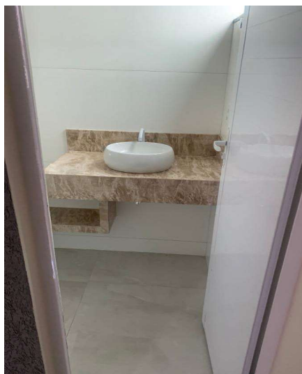
Representação Banheiro social Descrição Data Foto 05/12/2023
