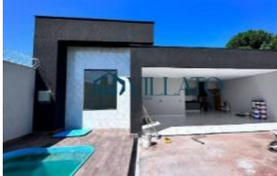
Representação Fachada Principal Descrição Data Foto 28/02/2024
