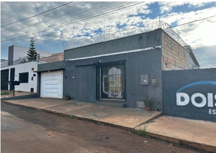
Representação Fachada Principal Descrição Data Foto 25/01/2024
