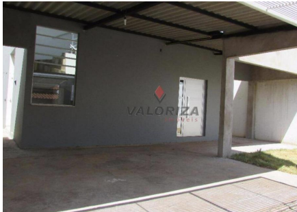
Representação Fachada Principal Descrição Data Foto 25/01/2024
