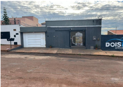
Representação Fachada Principal Descrição Data Foto 25/01/2024
