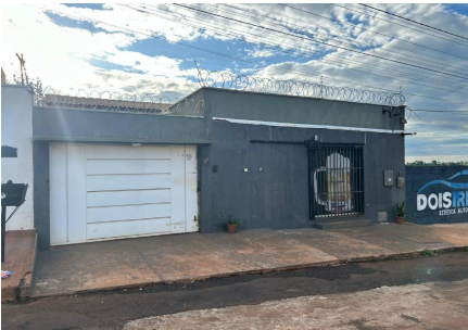
Representação Fachada Principal Descrição Data Foto 25/01/2024
