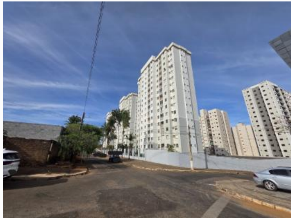
FACHADA DO CONDOMINIO
