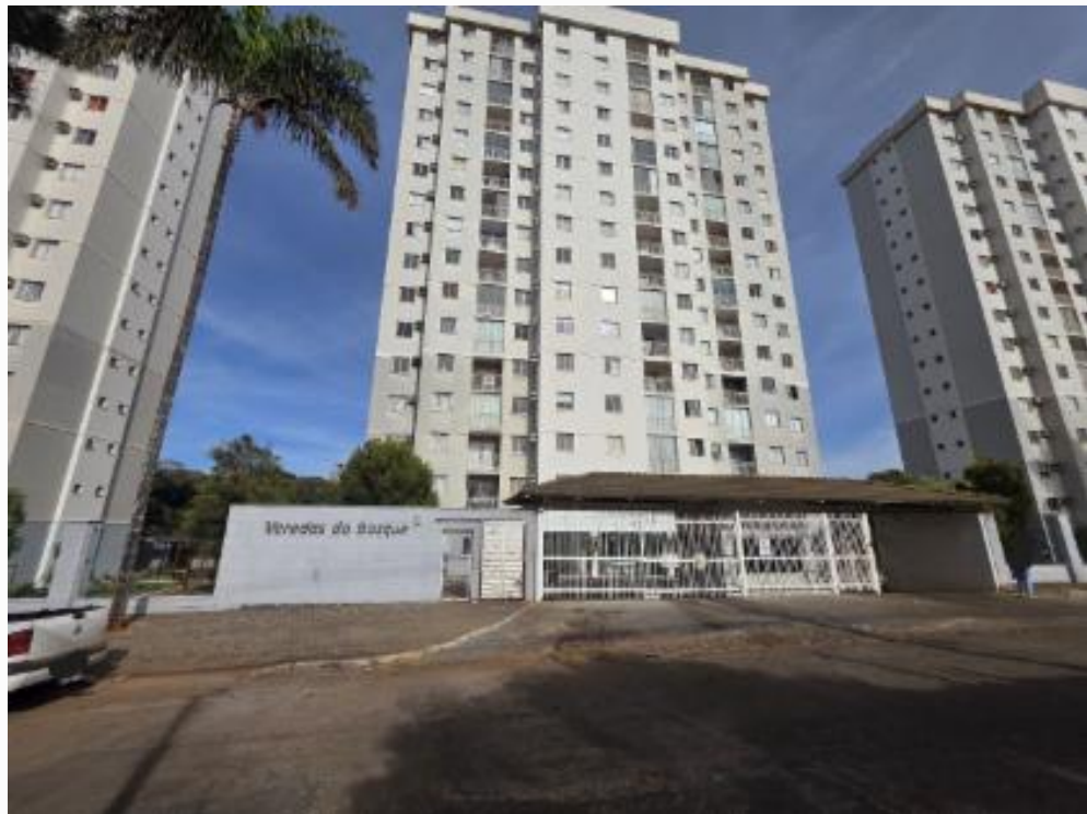
FACHADA DO CONDOMINIO
