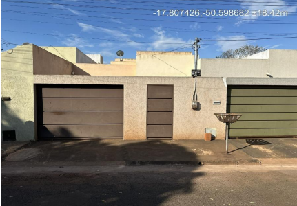
Representação Fachada Principal Descrição Fachada Data Foto 14/11/2023
