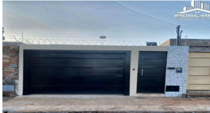
Representação Fachada Principal Descrição Fachada Data Foto 16/11/2023
