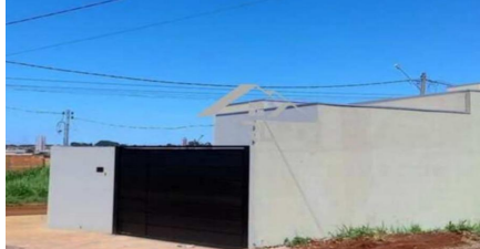
Representação Fachada Principal Descrição Fachada Data Foto 16/11/2023
