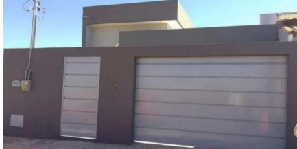
Representação Fachada Principal Descrição Fachada Data Foto 16/11/2023
