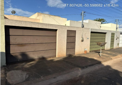
Representação Fachada Principal Descrição Fachada Data Foto 14/11/2023
