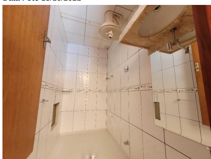
Representação Banheiro Descrição Data Foto 15/10/2021
