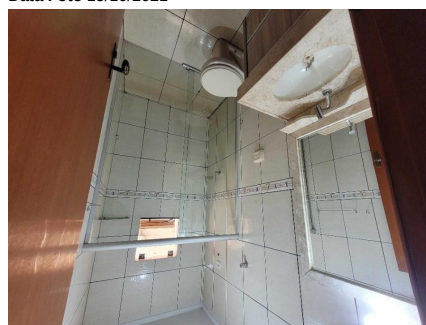
Representação Banheiro Suíte Descrição Data Foto 15/10/2021
