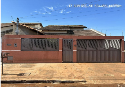
Representação Fachada Principal Descrição Data Foto 28/12/2023
