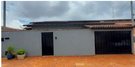
Representação Fachada Principal Descrição Data Foto 02/01/2024
