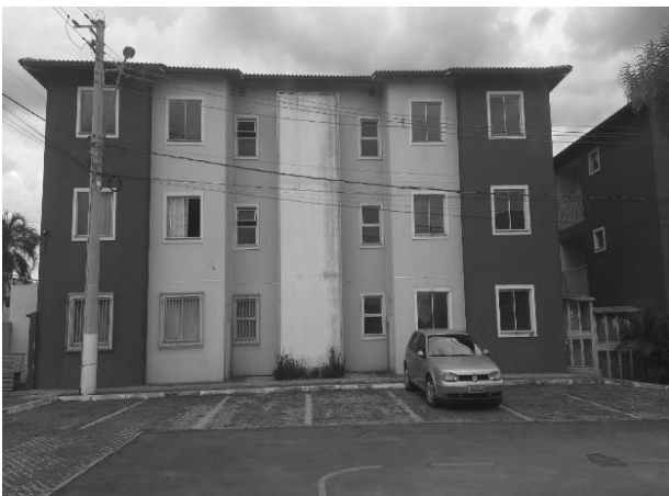
FACHADA DO BLOCO
