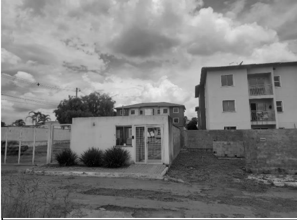
FACHADA DO CONDOMINIO
