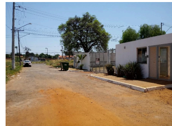
Representação Fachada Principal Descrição Rua abaixo Data Foto 08/10/2025
