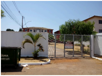
Representação Fachada Principal Descrição . Data Foto 08/10/2025
