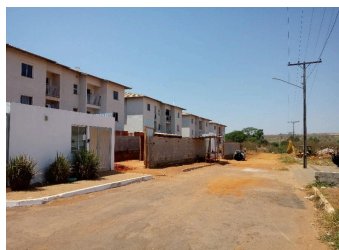
Representação Fachada Principal Descrição Vizinbo Data Foto 08/10/2025
