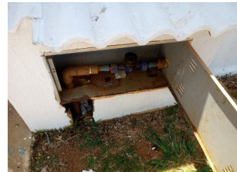
Representação Fachada Principal Descrição Cavalete Data Foto 08/10/2025
