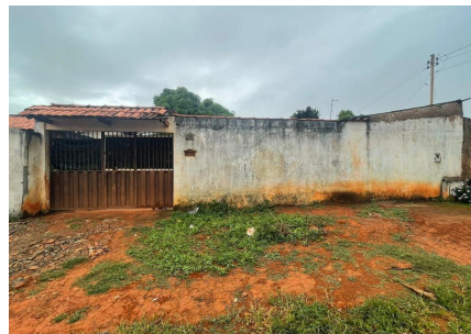
Representação Vista da Rua Descrição Vizinho à direita Data Foto 11/04/2024
