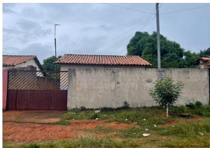
Representação Descrição Fachada do avaliando, vista 01 Data Foto 11/04/2024
