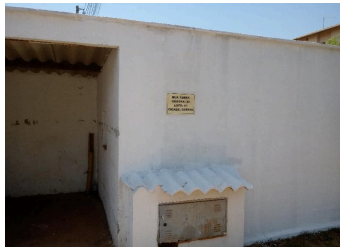
Representação Fachada Principal Descrição . Data Foto 08/10/2025
