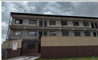
Representação Fachada Principal Descrição . Data Foto 08/10/2025
