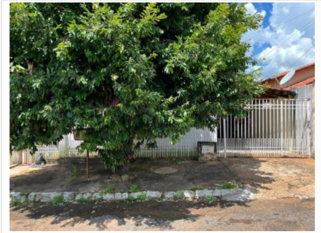
Fachada do avaliando, vista 01
