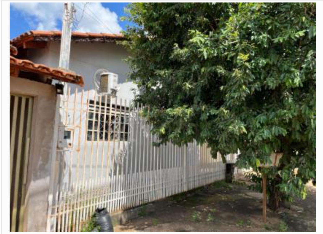
Fachada do avaliando, vista 03
