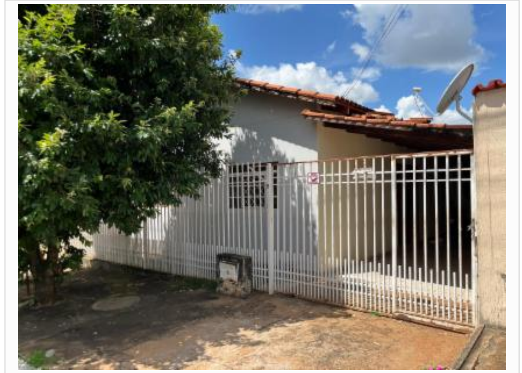
Fachada do avaliando, vista 04
