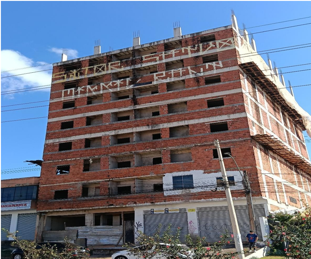
Foto tirada de frente ao Prédio
