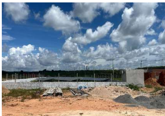
Foto 21 - Frente do loteamento, construção usina fotovoltaica
