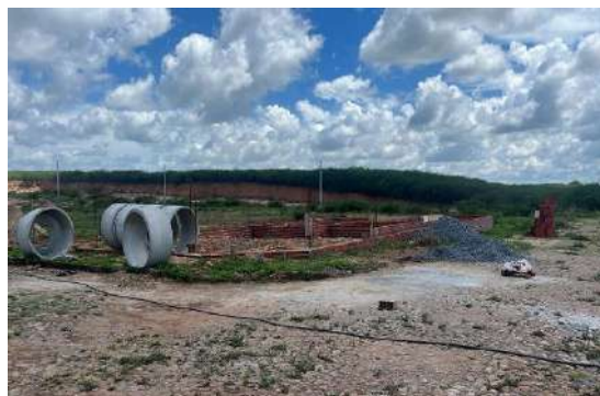
Foto 20 - Frente do loteamento, construção usina fotovoltaica
