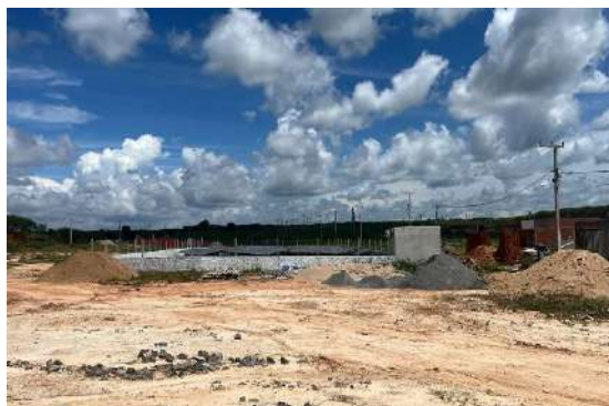
Foto 19 - Frente do loteamento, construção usina fotovoltaica
