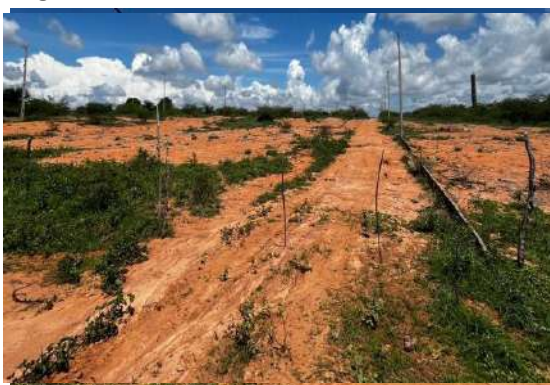
Foto 10 - Acesso para os fundos do loteamento com cerca de arame
