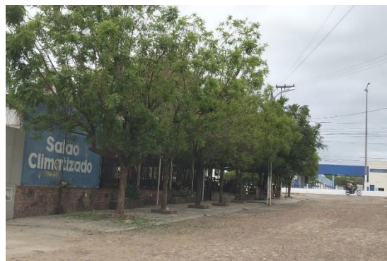
Foto 10 - Vista do imóvel avaliando pela lateral (Rua das Porteiras)
